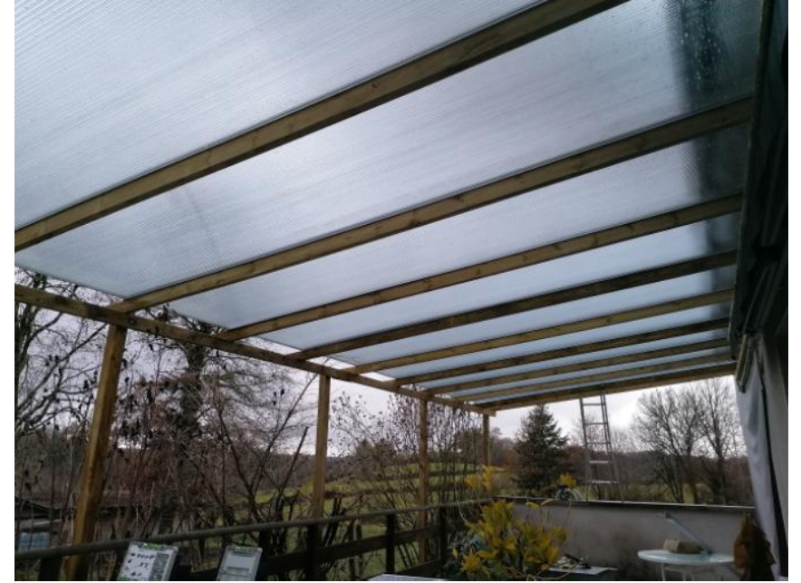
Pergola ossature en pin classe 4 avec une toiture en polycarbonate de 16 mm.
